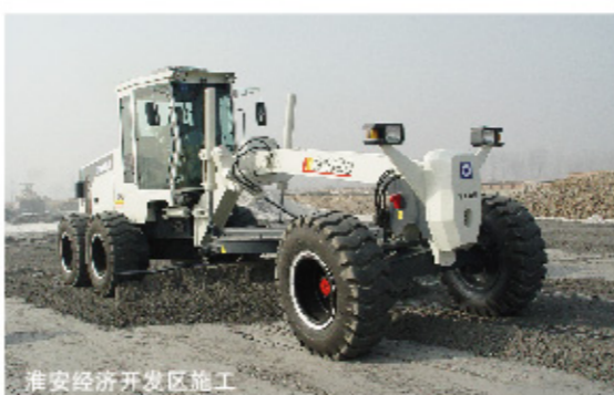
淮安经济开发区施工
