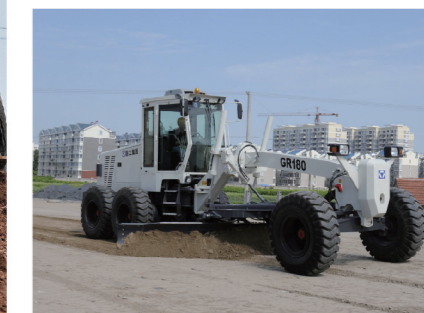
Строительные работы по сооружению шоссе между провинциями в Шаньдуне
