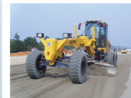
Строительство шоссе Дашан
