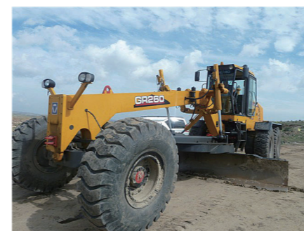
Строительные работы в карьере Эрдос
