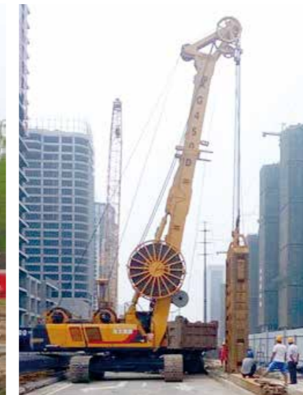
Строительство станции метро Kangning Road 5 линии города Чжэнчжоу Kangning Road Station of Line 5, Zhengzhou Subway
