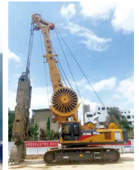
Строительство станции метро Garden Station города Куньмин Small Garden Station of KunMing
