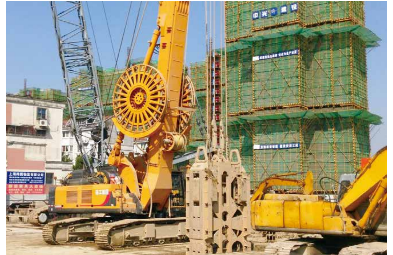
Строительство станции CaoYing, 17 линии Шанхайского метро. Ширина траншеи составляла 1200 мм, а максимальная глубина 55 м. Грейферная установка XG600D работала стабильно и эффективно в данном проекте, и получила хорошие отзывы от операторов.
