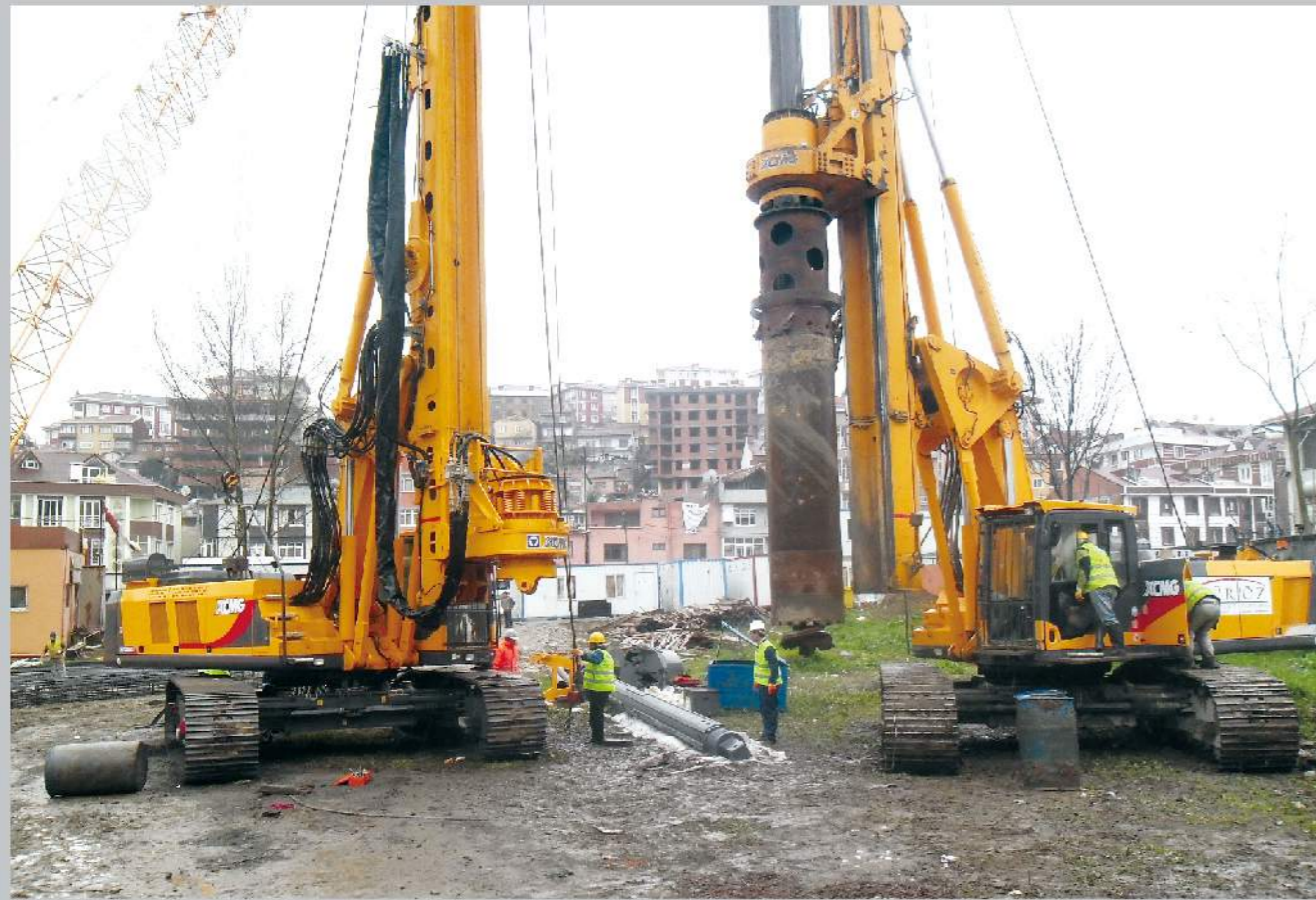
旋挖钻机在土耳其施工 XCMG rotary drilling rigs in Turkey
